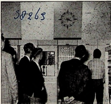
DE BEIDE TABLEAUS waarop resp. de „contributie” en de „distributie” kanalen over Nederland met lichtsignalen worden aangegeven. Alle TV zenders en straalzendersteunpunten zijn aangegeven. De onderlinge afstand van max. 50 km garandeert een uitstekende signaal/ruis verhouding (50 dB).
